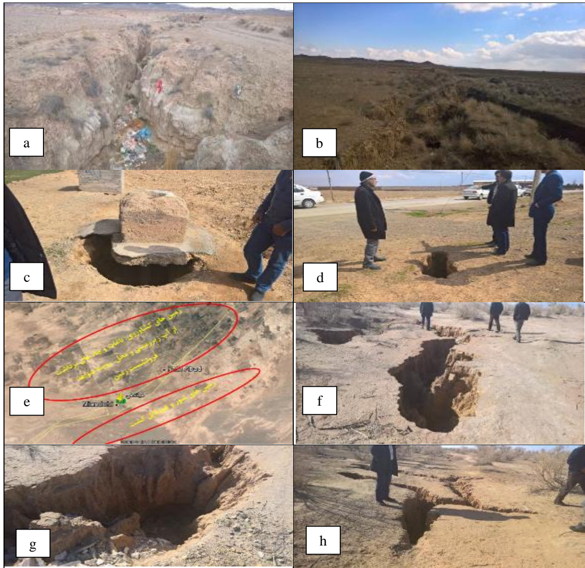
شکل ۱۶: a، b، c، d: شکاف ها و فروچاله ناشی از فرونشست زمین در روستای سلطان آباد، e، f، g، h: شکاف ها و فروچاله ناشی از فرونشست زمین در روستای میاندهی
